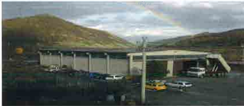
(Figura n.1: Capannone per il ricovero dei mezzi di Solignano)
